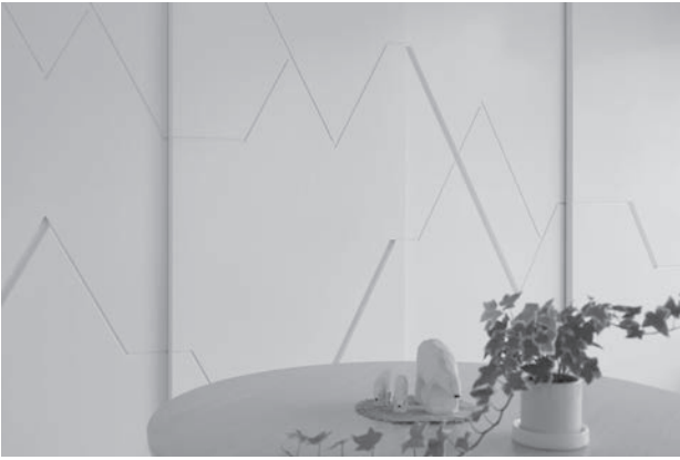
図 11 リビング兼ダイニングの収納建具の表面に施された掘り込み模様。自然の山並みをイメージしている。掘り込み自体が建具開閉のための取手の役目も担っている。
